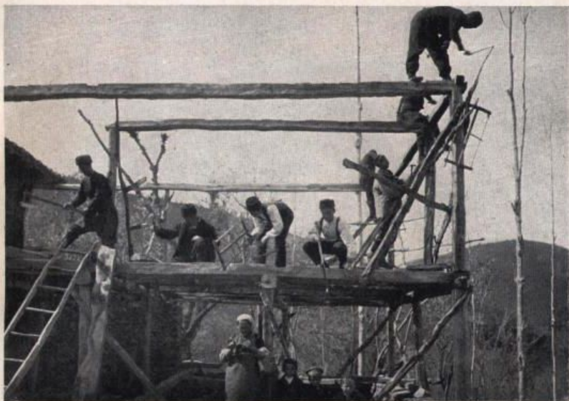
1. Първа работа при построяване керемидна кжща въ с. Райчиловци.
