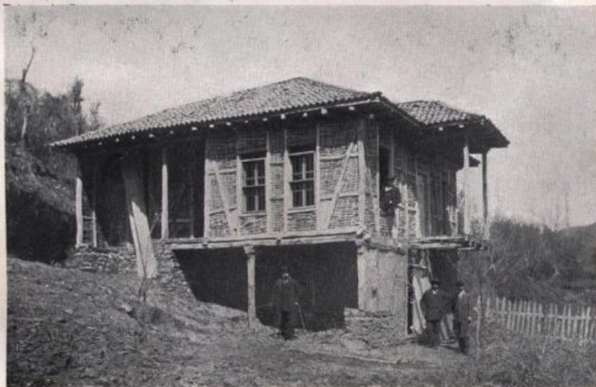
2. Сжщата къща изплетена съ пръчки — готова за първа мазилка.
